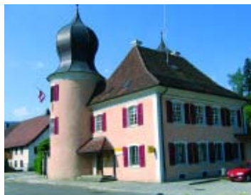
Château de Fontenais
